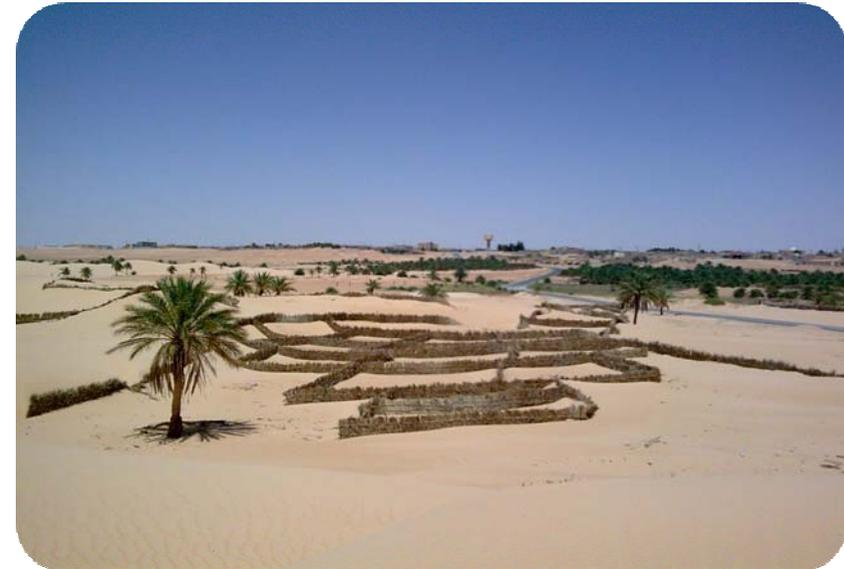
**Figure 2.** Carroyage de palmes destinées à protéger la section routiers d'Aïn Beïda vers Sidi Khouiled (W Ouargla)
