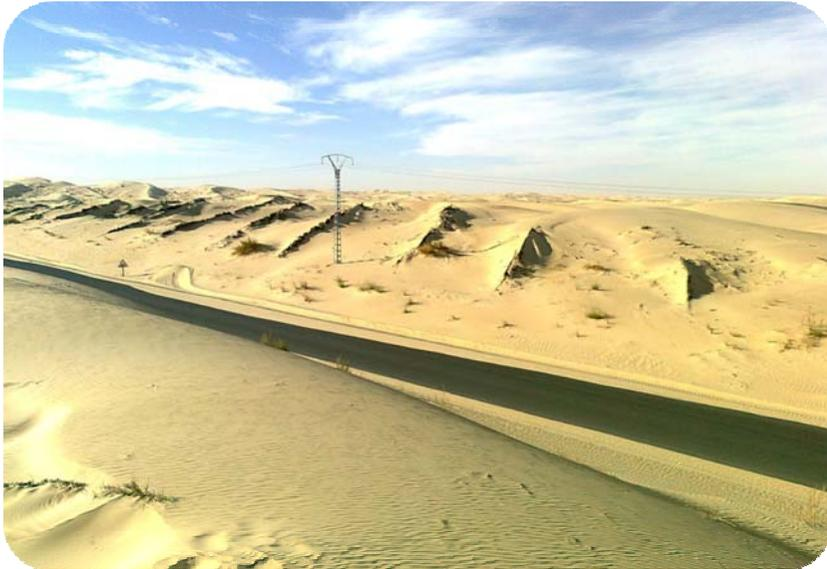
**Figure 20.** Palissades à base de palmes déposées obliquement par rapport à la route à protéger (El Oued Souf-Robbah)
