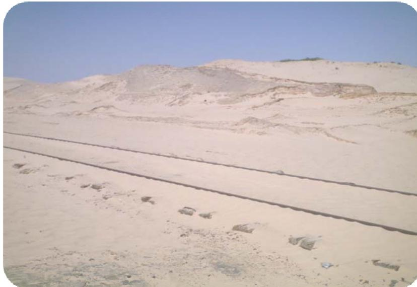
**Figure 3.** Epannage de dérivés de pétrole (bitume) pour protéger la voie ferrée contre l'ensablement (Biskra\_ Touggourt)
