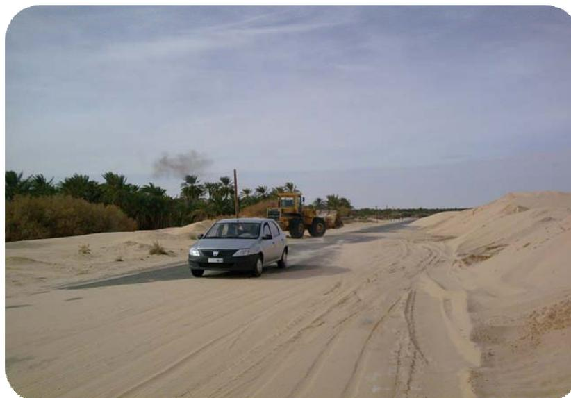
**Figure 16.** Des trains barkhaniques provoquant l'ensablement et causant des dégâts importants sur les oasis et la route (cas d'EL Goug-Temacine. W Ouargla)
