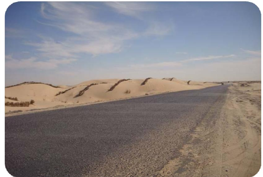
**Figure 19.** Palissades successives déposées perpendiculairement à la direction du vent dominant (Robbah-Oued Souf)
