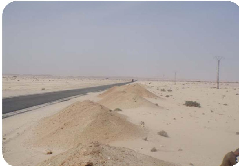
**Figure 10.** L'efficacité des Drâas implantés en biais sur la route Touggourt-Djelfa
