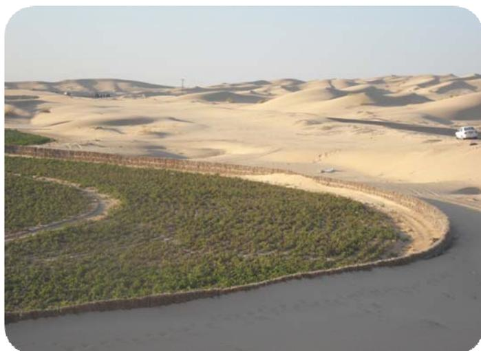
**Figure 37.** Palissade à base de palmes concentriques pour protéger la culture de la pomme de terre sous pivot contre les flux éoliens (Robbah, Oued Souf).
