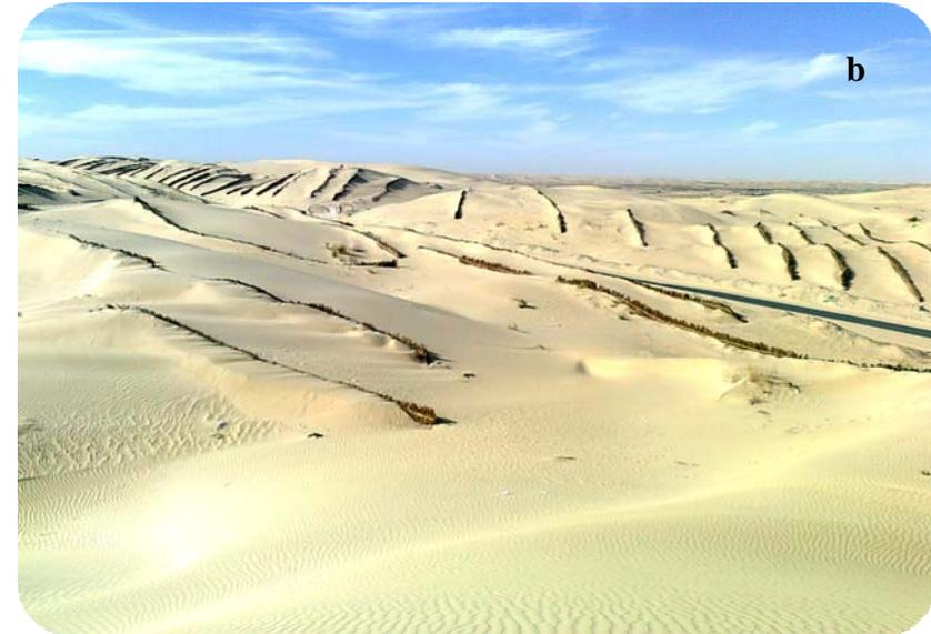
**Figure 18 :** (a) et (b) un exemple concret d'un dispositif expérimental de stabilisation des grosses dunes (30 à 40 m de hauteur) sur le tracé routier (El Oued Souf vers Robbah)
