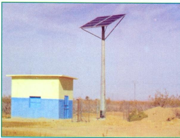
**Figure 08 : Installation d'énergie solaire pour le pompage de l'eau en zone de parcours (Ain Naga, Algérie)**
