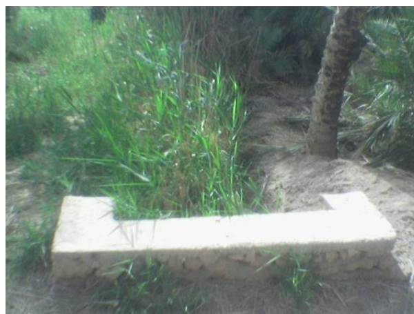
Figure 5 : Drain secondaire dans la palmeraie du ksar d'Ouargla.
